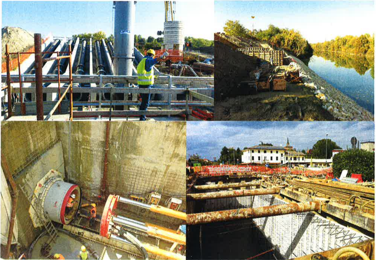
Lavori di costruzione dello Scolmatore di piena Limenella-Fossetta (Padova)
