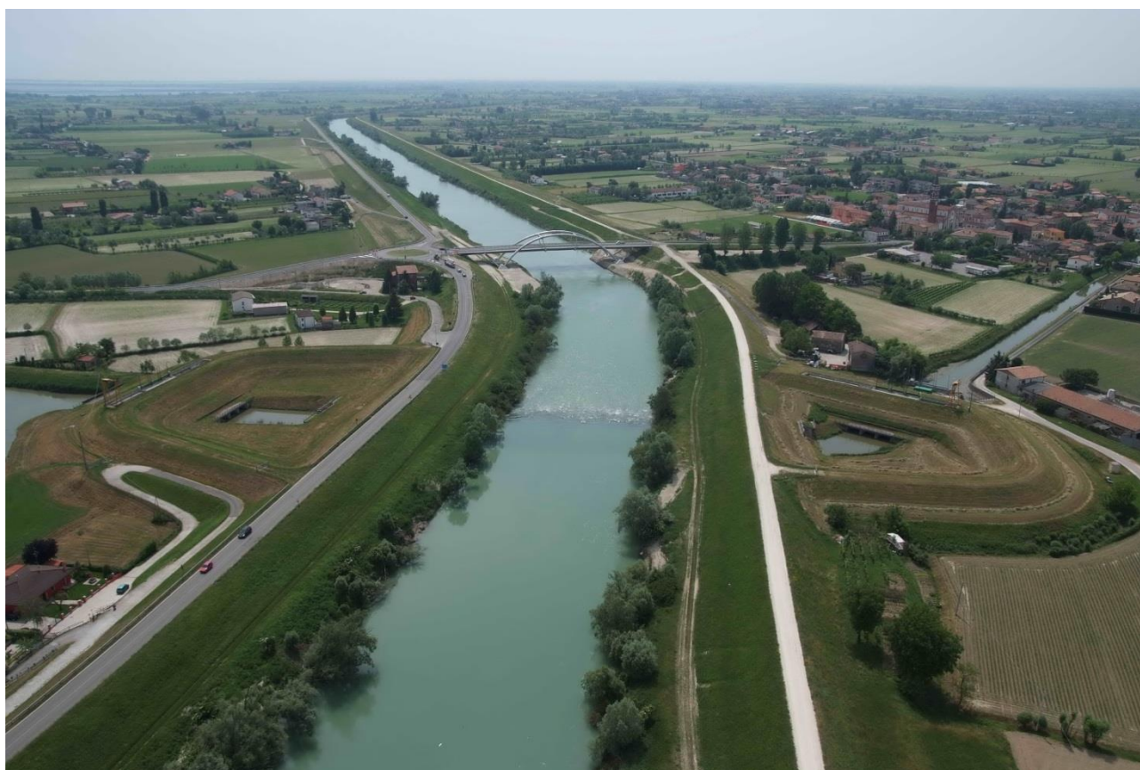
Botte a sifone sottopassante il fiume Brenta a Corte di Piove di Sacco
