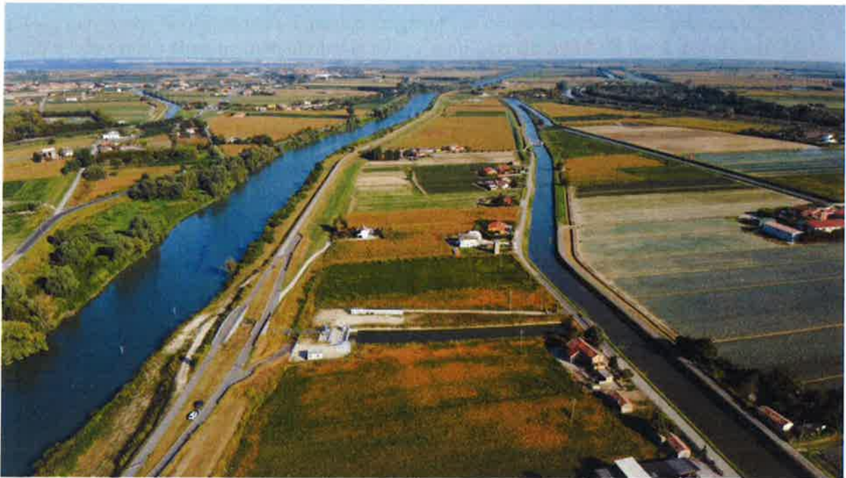
Il nuovo impianto idrovoro Altipiano con scarico nel fiume Brenta a Codevigo
