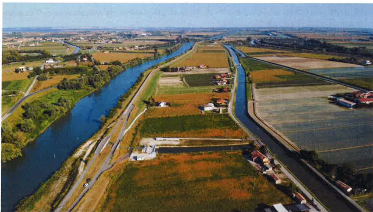
Il nuovo impianto idrovolto Altipiano con scarico nel fiume Brenta a Codevigo
