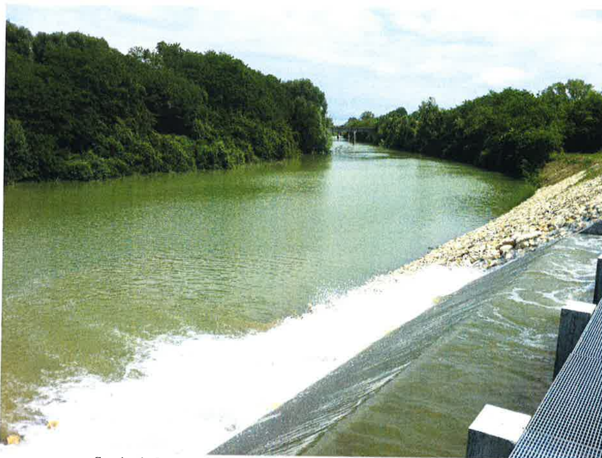
Scarico in Brenta dello scolmatore di piena Limenella Fossetta a Padova
