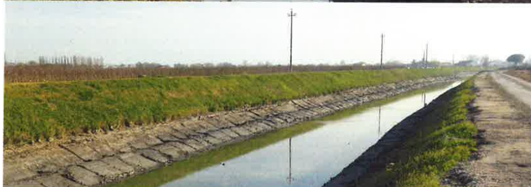
Lavori di ricalibratura del canale Altipiano a Codevigo
